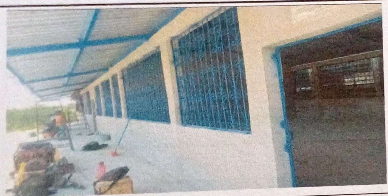
Foto 3: Se puede observar que los balcones ya estan instalados.
